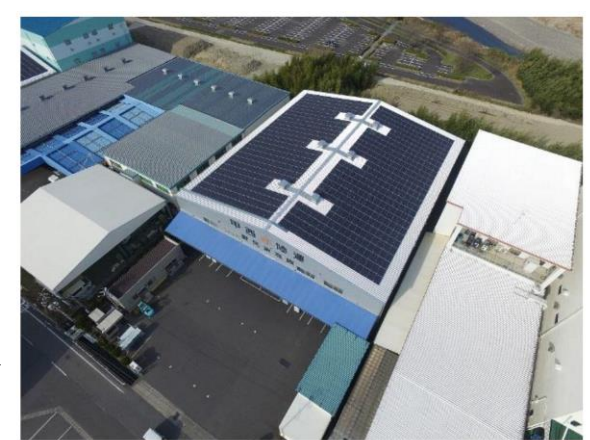
夏見東太陽光発電所
