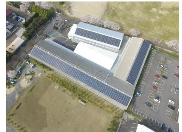
野洲川太陽光発電所
