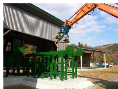
木質バイオマス製造施設
