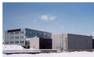
庁舎全体(左:本館 右:雪室)
