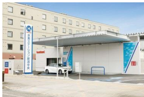
水素ステーション(新潟市)
