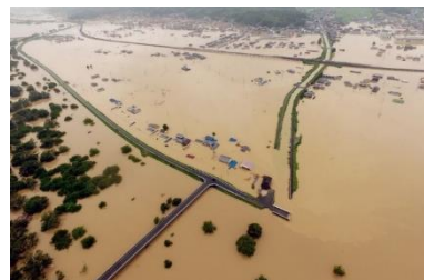
倉敷市真備地区被災状況(H30.7.7)
