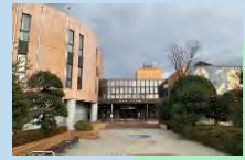
(仮称)ひと・夢・未来創造拠点複合施設を整備中
