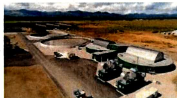
【町内のバイオガスプラント】
