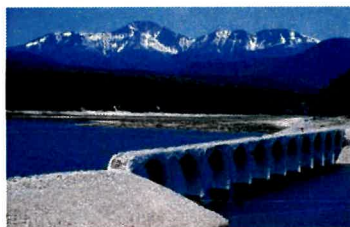
【タウシュベツ川橋梁】
