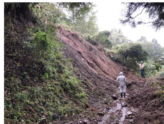
(令和元年台風19号による被害)
