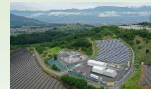
電力貯蔵技術研究サイト（P2Gシステム）
