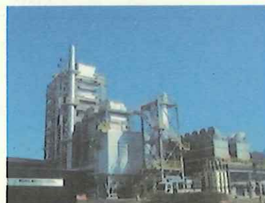
市内の木質バイオマス発電所
