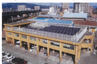
出典) 久留米市環境部庁舎のZEB化事例
