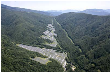
五葉山太陽光発電所(発電出力18MW)
