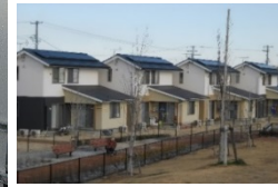
▲災害公営住宅にソーラーパネルを設置（設置戸数：149戸）
