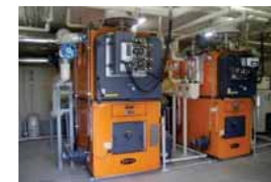
木質バイオマスボイラーイメージ
