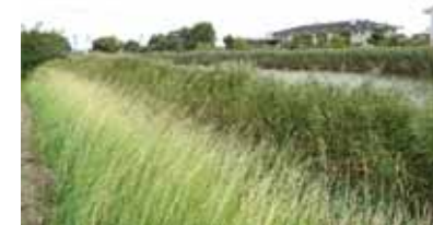
【環境配慮型の工法の例(自然護岸の調整池)】
