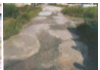
農道の窪みの補修
