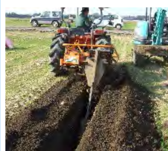
暗渠排水の整備
