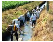
水路の泥上げ
