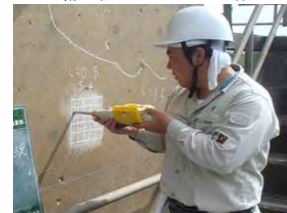
老朽化した施設の機能診断
