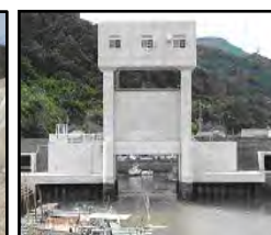
津波・高潮対策としての水門整備
