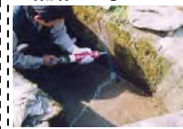
水路のひび割れ補修
