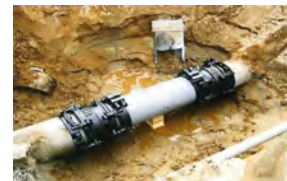
漏水防止のための整備
