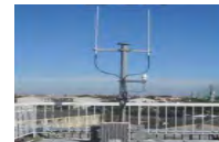
通信施設の整備
