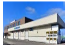
集出荷・貯蔵・加工施設の整備
