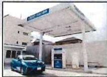
水素ステーション (提供：静岡ガス(株))
