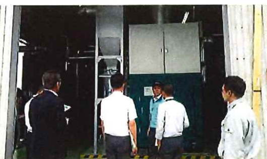
2017.10.2 市関係課によるバイオマス熱利用設備視察
