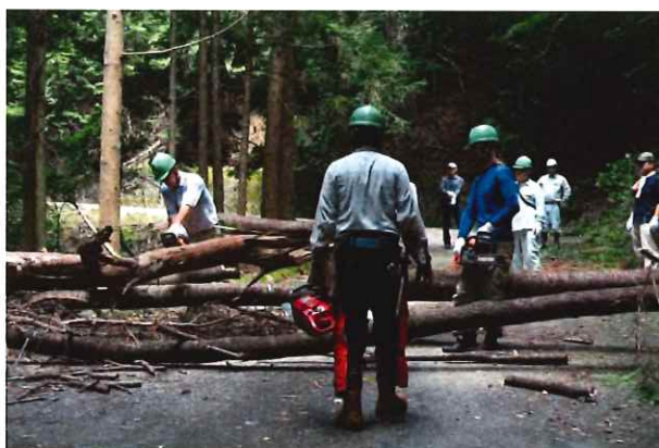
稲武地区 林道整備
