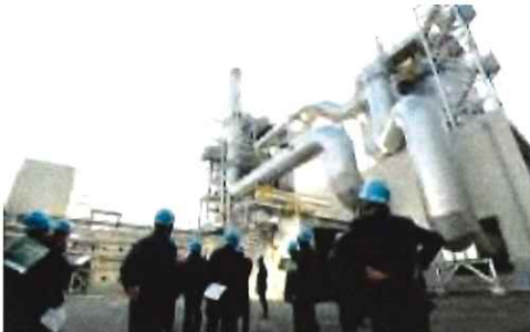
バイオマス発電所
