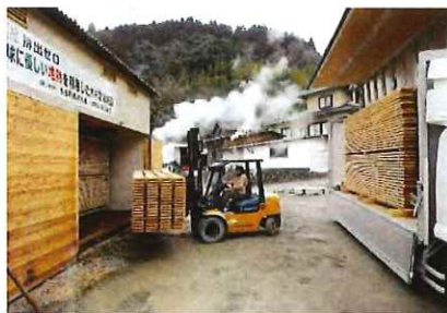
わいた地区で稼働する地熱による木材乾燥施設
