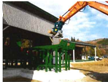
中津川木質バイオマス製造施設
