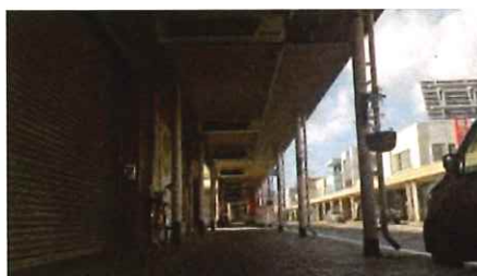
商店街のシャッター通り化(見附地区商店街)
