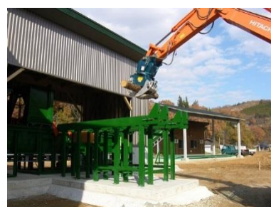
木質バイオマス製造施設
