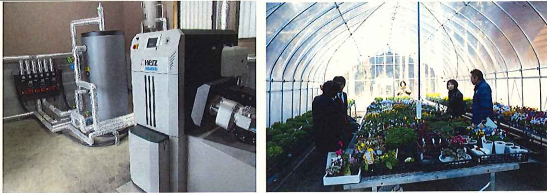
秩父宮記念公園バイオマスボイラー・貯湯タンクと花苗育苗温室(熱供給)
