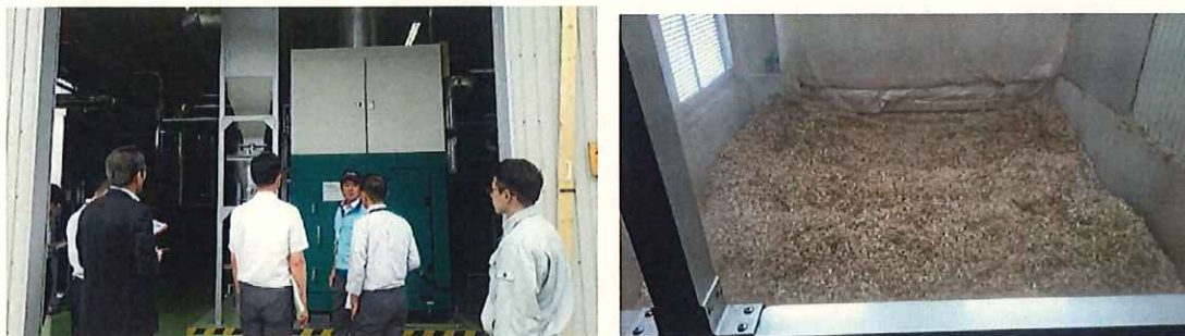
リコー環境事業開発センターバイオマスボイラー(冷暖房と給湯用)とチップサイロ
