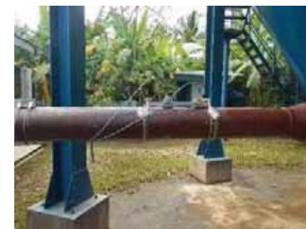
日本製流量計を活用した流量の把握 （浄水場での水収支管理）
