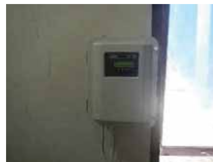
日本製流量計を活用した流量の把握 （浄水場での水収支管理）
