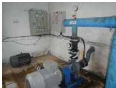
配水圧力の管理 (圧力計取付)
