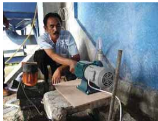
日本製薬液ポンプの活用 （長寿命、注入量の安定化）
