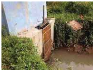
取水口 (河川とのレベルに課題あり)
