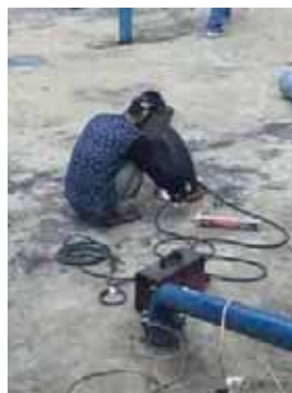
ポンプ吸込配管改良 (φ100→200)
