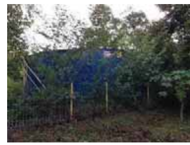
配水池 (標高差160m?)
