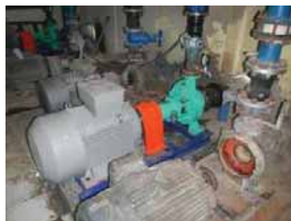
日本製配水ポンプ設備の活用 （長寿命、高効率、配水の安定化）
