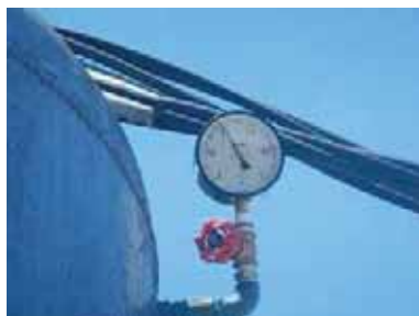
配水圧力の管理 (圧力計取付)
