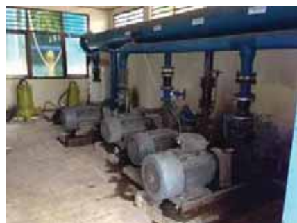
非効率な配水ポンプ設備
