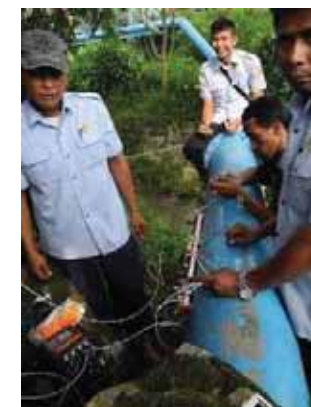
配水管の流量把握
