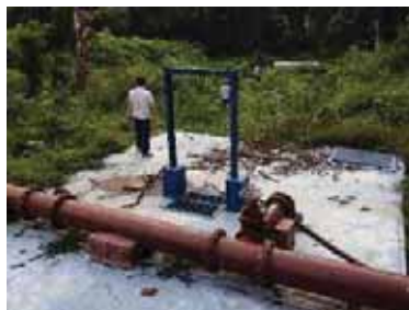
取水ポンプ井 (水が無い)
