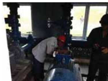
送水ポンプ設備 (軸動力と電動機 出力ミスマッチ)
