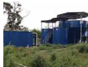
浄水設備 (能力:30l/s)
