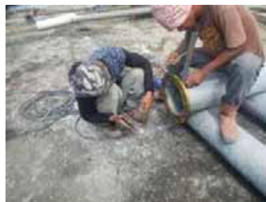
ポンプ吸込配管改良 (φ100→200)
