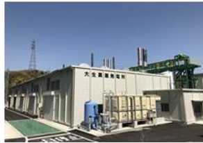
(木質バイオマス発電所)
