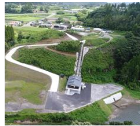
(小水力発電所)
