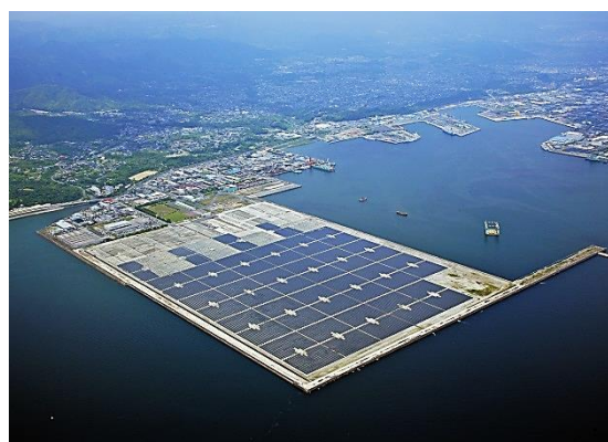
鹿児島七ツ島 メガソーラー発電所
