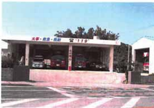
金武地区消防 恩納分遣署
