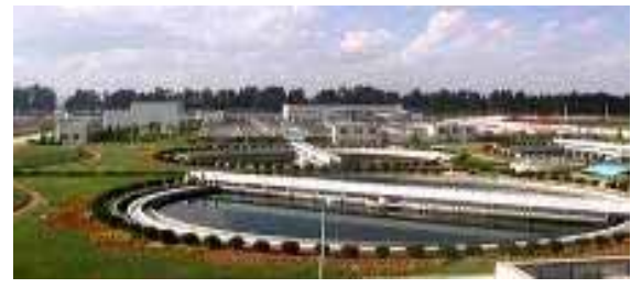
昆明市下水処理場
