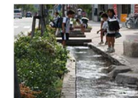
公園、防災まちづくり のせせらぎ用水
