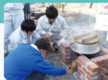
防災かまどベンチ (通常はベンチとして利用し、非常時には炊き出しができるかまど)
