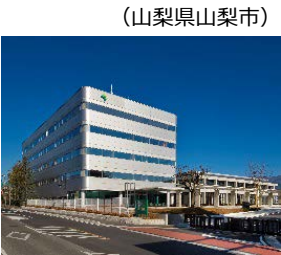
（山梨県山梨市） 市役所本庁舎
