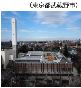
武蔵野クリーンセンター
