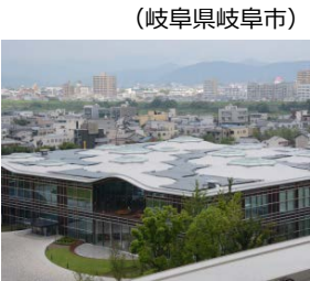
（岐阜県岐阜市） 太陽光発電、太陽熱利用設備、地中熱ヒートポンプを導入したみんなの森 ぎふメディアコスモス
