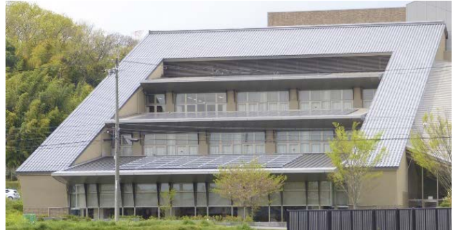
北コミュニティセンターISTAはばたきの屋根に設置した防災型太陽光発電システム
