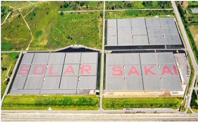
堺太陽光発電所（10MW）
