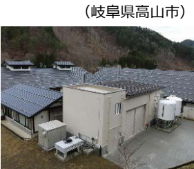
（岐阜県高山市） 温浴施設「しづきの湯 遊湯館」に整備された「飛騨高山しづきの湯バイオマス発電所」
