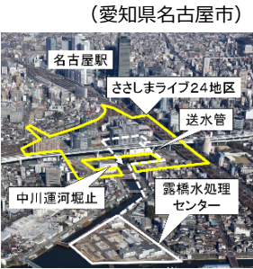
（愛知県名古屋市） 下水熱活用による地域冷暖房事業
