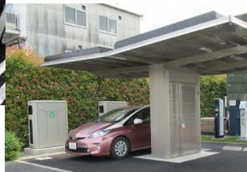
左上：Ha:mo貸出ステーションの様子 右下：PHVの廃バッテリーを活用した蓄電システム@エコフルタウン
