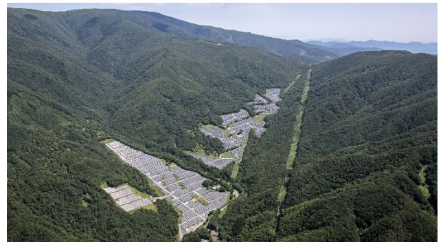
五葉山太陽光発電所（発電能力：18MW）
