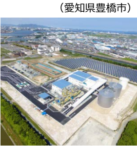
（愛知県豊橋市） 豊橋市バイオマス利活用センター
