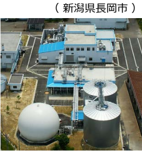
（新潟県長岡市） 生ごみバイオガス発電センター
