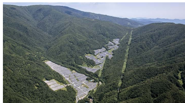
五葉山太陽光発電所（発電能力：18MW）
