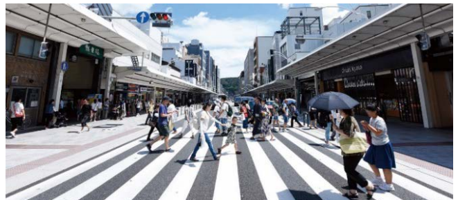
歩道拡幅整備後の四条通。「四条通歩道拡幅事業」は多角的な視点から評価をいただいており、国際交通安全学会から交通の視点、日本都市計画学会からまちづくりの視点、土木学会から土木技術の視点、全国街路事業促進協議会から街路整備の視点で、それぞれ表彰を受けています。
