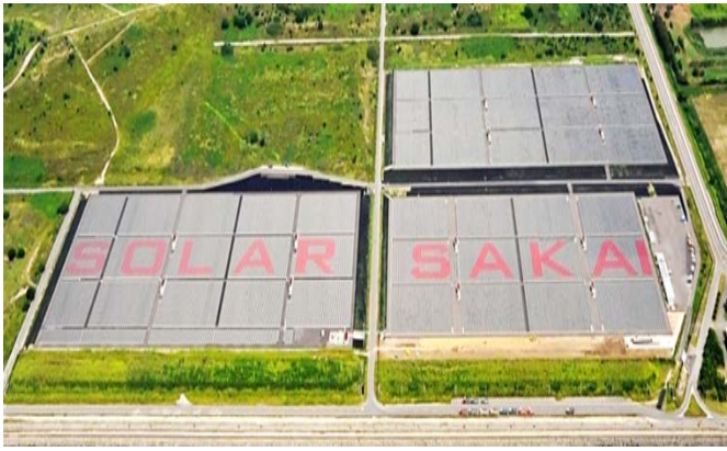
堺太陽光発電所（10MW）
