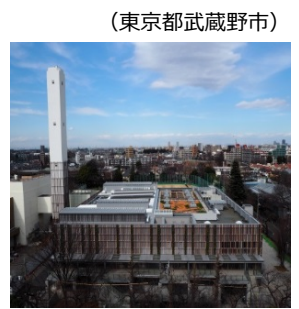
武蔵野クリーンセンター
