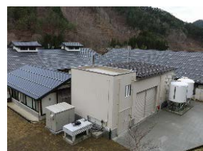
温浴施設「しづきの湯 遊湯館」に整備された「飛騨高山しづきの湯バイオマス発電所」
