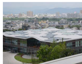
太陽光発電、太陽熱利用設備、地中熱ヒートポンプを導入したみんなの森 ぎふメディアコスモス
