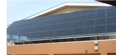
小学校に設置された太陽光パネル
