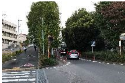
現状の外環側道部
