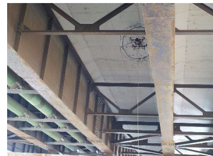
橋梁点検の実証実験
