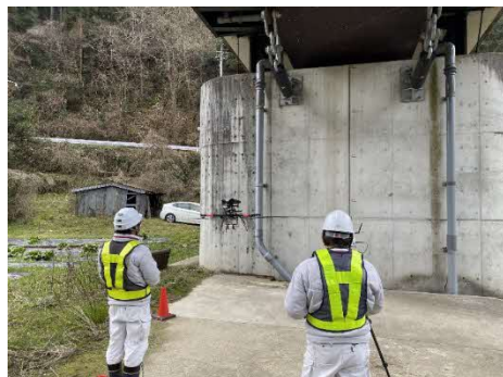
（ドローンによる橋脚点検状況）
