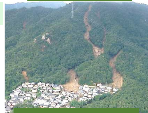
H30.7豪雨災害 広島県熊野町
