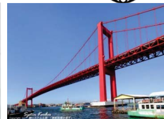
橋梁、トンネル
