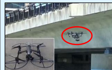
▲ インフラ (橋りょう) 点検
