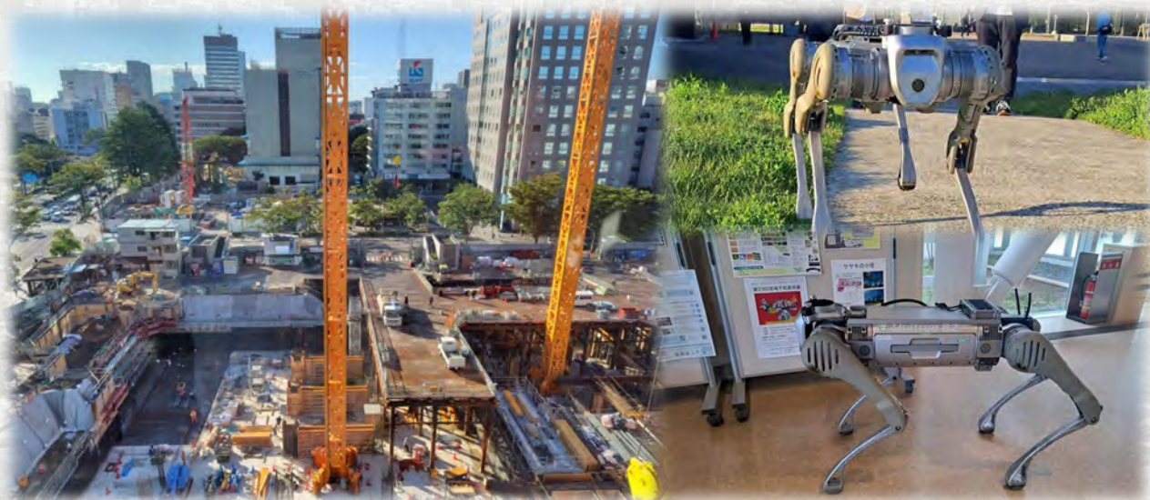
新本庁舎工事現場における巡視業務省力化に関する実証
