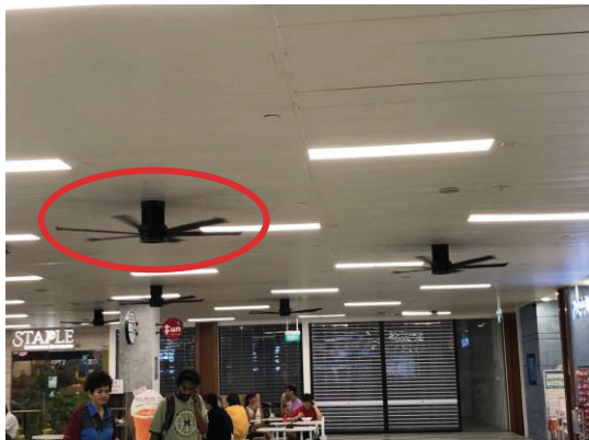
気温・湿度センサーと連携して制御が自動化された屋内ファン
