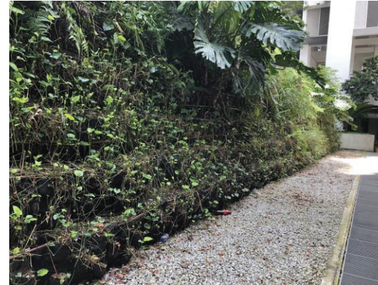
狭い空間でも緑地面積が最大化され、 また灌漑が自動化された緑化空間
