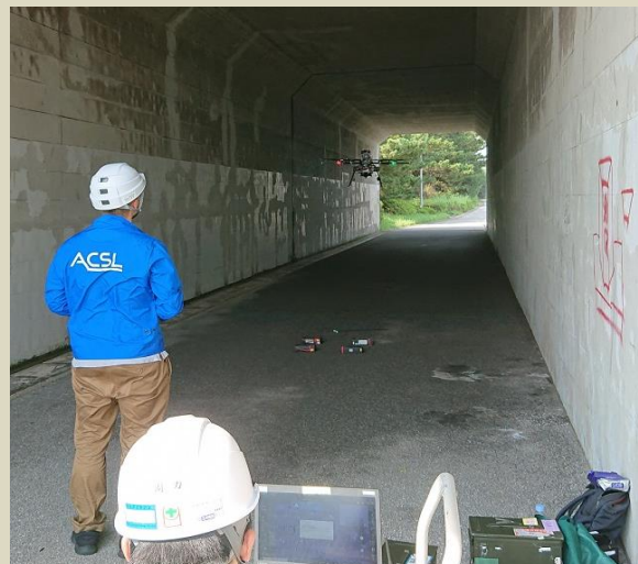
トンネル内(非GPS環境)の非接触点検
