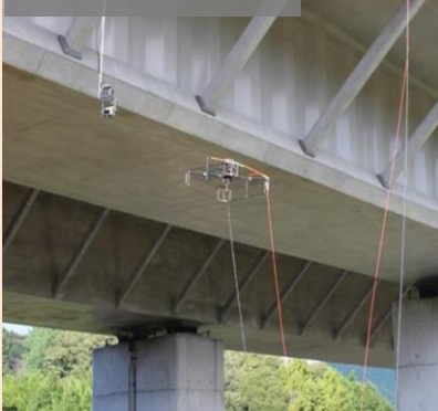
▼高速道路橋梁
