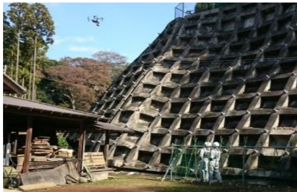
・急傾斜地崩壊防止施設変状把握調査
