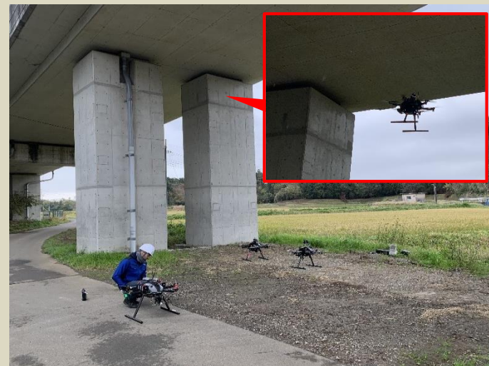
コンクリート橋(非GPS環境)の非接触点検
