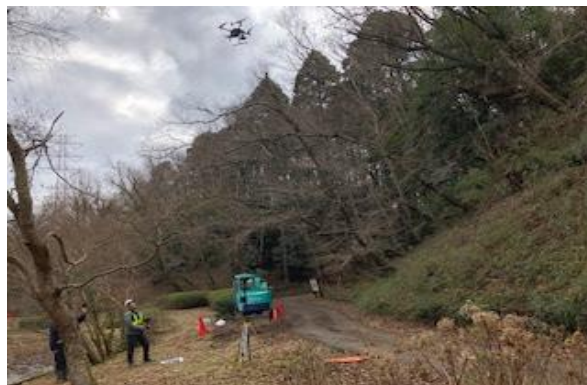
・公園斜面防災カルテ作成
