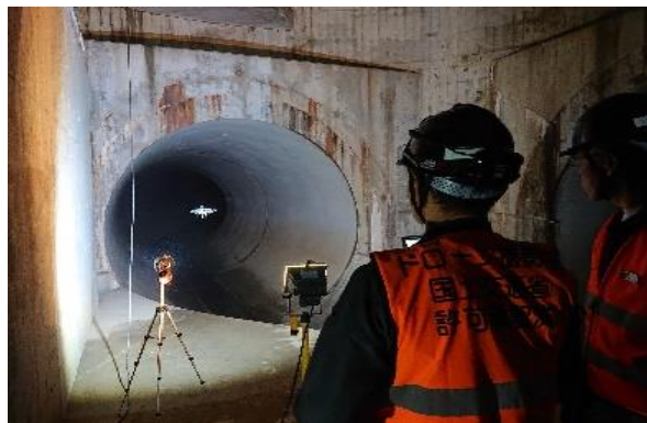
・大規模雨水貯留施設点検調査
