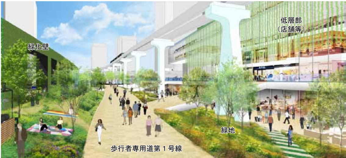
敷地南西から浜松町駅方面を望む
