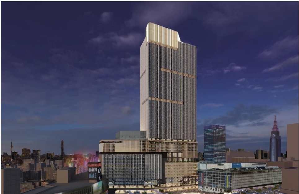
駅前広場北西から計画地を望む
