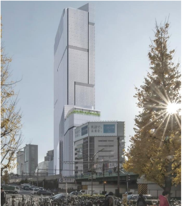
西武新宿駅側より計画地を望む
