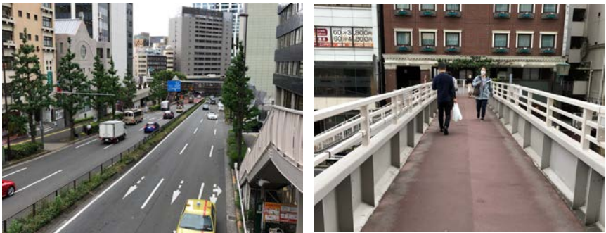
幹線道路による市街地の分断 通行幅員が狭い金王坂歩道橋
