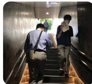
狭隘な地上と地下の連絡階段（1番出口）
